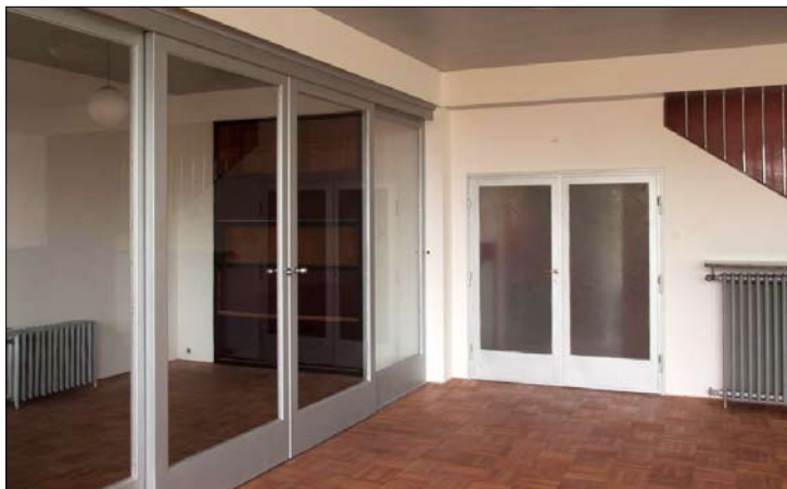
Obr. 9: Brno, Lipová 17, Žáčkova vila. U dvoukřídlých otevíracích dveří jsou použity obdobně vyráběné válcované profily, opatřené šroubovanými zasklivačmi lištami z plného válcovaného profilu. Celý soubor dveří včetně rámu a zasklení je originální. U těchto dveří se zachovaly jak nepoškozené závěsy, tak zástrče pevného křídla, zasklení mrazovým sklem, kování z bílé mosazi, zámek, krytky i klíč. I nátěry jsou původní. Z chodby je nátěr bílý, ze strany halý je nátěr stříbrný. Jsou jím natřeny všechny ocelové konstrukce. Zajímavostí je, že architekt E. Žáček ve stejném odstínu natřel i strop těchto prostor.
