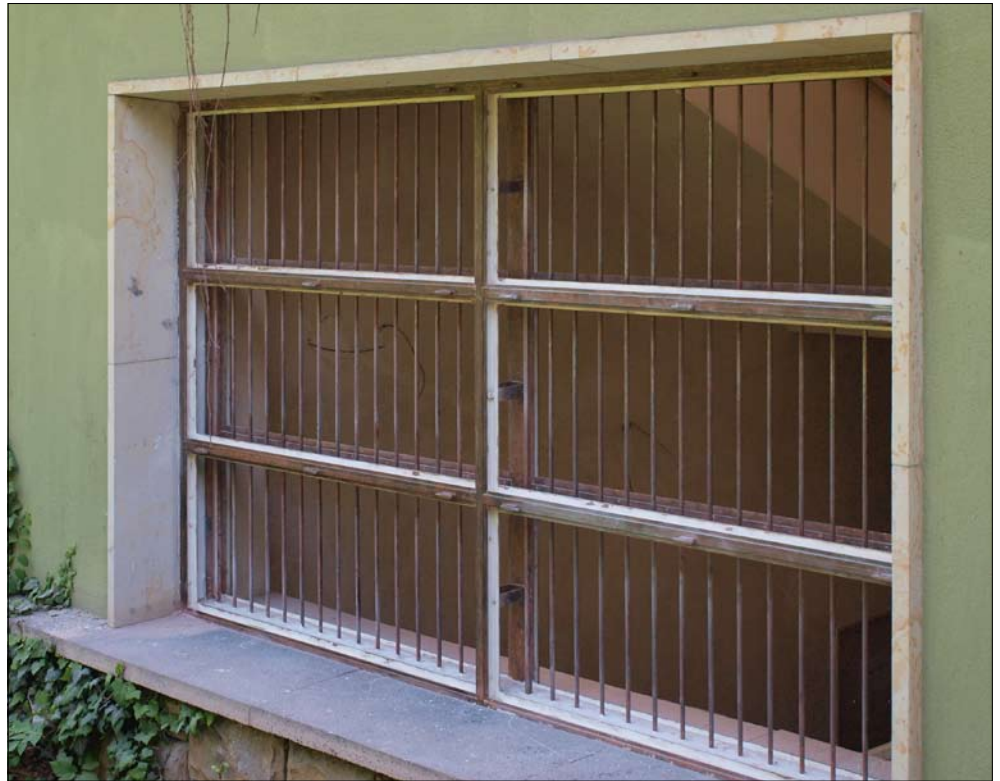
Obr. 32: Brno, Hroznová 14, vila Stiassni. Prosklená část schodišťové stěny s množstvím sprážených ventilačních křídel ovládaných pákami. Při rekonstrukci se podařilo zachovat nejenom značné množství původních nátěrů, ale i část skel včetně tmelu.
