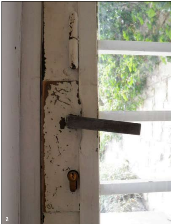
Obr. 30: Brno, Hroznová 14, vila Stiassni. Ocelové ochodové dveře opatřené z vnější strany robustní mříží z válcovaných ocelových profilů o čtvercovém průřezu: a – dveře jsou prosklené, přičemž prosklení lze samostatně otvírat; b – chybějící původní kování bylo nahrazeno hliníkovou klíkou. Při rekonstrukci byly vyrobeny kopie původního kování. Až na poškození nátěrů kolem kování byly nátěry v takovém stavu, že je nebylo nutno odstranit. Po přebroušení a dotmelení byly přetřeny.
