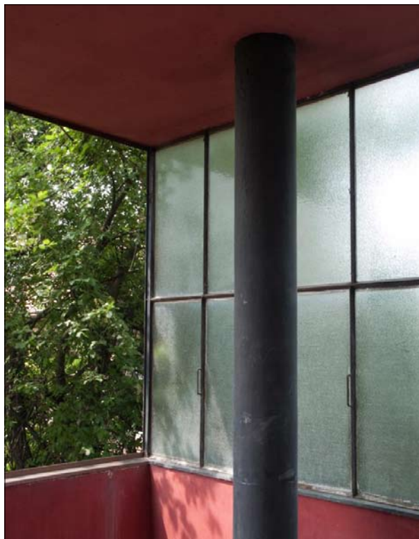
Obr. 27 b: Brno, Lipová 17, Žáčkova vila. Prosklená stěna terasy s původním zasklením.
