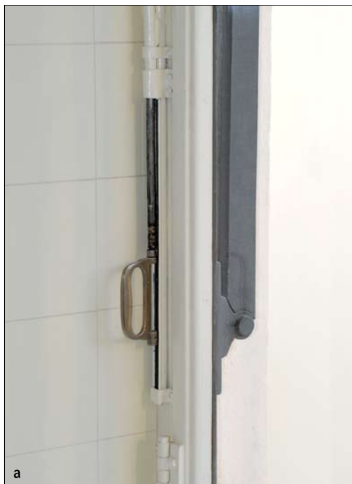
Obr. 20: Brno, Černopolní 45, vila Tugendhat: a – madlo ovládacího táhla ventilačního křídla na soisle otočném čepu, odlité z tzv. bílé mosazi; b – chromované okenní kličky na okně v kuchyni.
