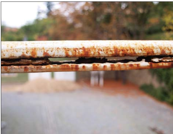
Obr. 33: Brno, Hroznová 14, vila Stiassni. Ocelové zábradlí lodžie. Patrná naprostá destrukce nátěru a poškození vlastní konstrukce masivní spárovou konstrukcí. V tomto případě bylo nutné razantně zasáhnout přímo do konstrukce zábradlí. Madlo zábradlí je složeno ze dvou snýtovaných profilů, plochého a půlkulatého. Nýty se odvtaly a oba profily bylo nutno přerovnat, opatřit několika vrstvami antikorozní bariéry Libert, znovu opatrně snýtovat tak, aby nebyla poškozena antikorozní bariéra a finálně přetřit pohledovými vrstvami. Zábradlí nebylo možné demontovat a celý technologický postup byl proveden na staubě. U všech konstrukcí meziválečné doby, které jsou v jádru skládány, je spárová koroze nejnebezpečnější jev, protože úgrobky deformuje a nelze ji odstranit tak jako korozi povrchovou. Pro odstranění spárové koroze je vždy nutné dané profily od sebe oddělit, odstranit korozi, stabilizovat povrch, nanést antikorozní bariéry a znovu profily spojit nýty nebo šrouby. Při těchto postupech vždy dochází k podstatným ztrátám autenticity.
