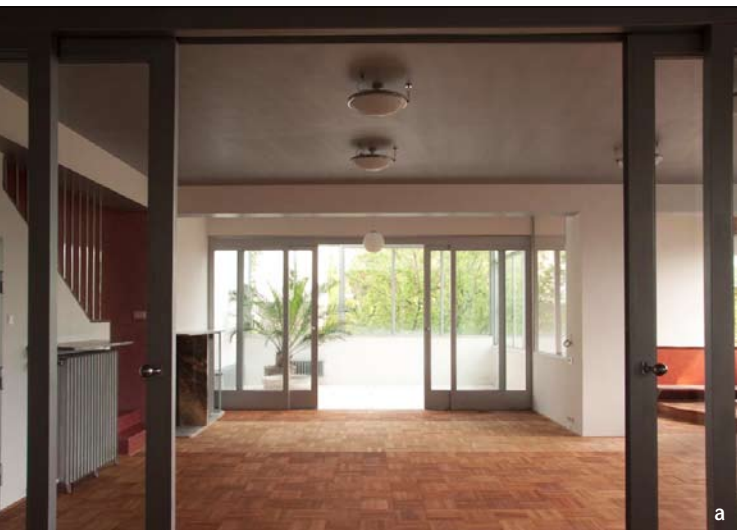
Obr. 10: Brno, Lipová 17, Žáčkova vila: a – ocelová prosklená čtyřdílná stěna osazená dvěma posuvnými křídly v reprezentativních prostorách vily. Jedná se o typický příklad dělení interiérových prostor tak, aby se opticky nezmenšoval. Ocelový rám je vytvořen z válcovaného profilu, který je vyroben přímo pro tento typ dveří a není skládán. Našroubovány jsou pouze klapáčky a zasklivač lišty. Rám je zavěšen na závěsy Perkeo kryté tvarovanou vyválnou lištou vyrobenou zřejmě přímo pro krytí tohoto typu dveří. Podlahové vedení tvoří velmi subtilní T profil o délce cca 50 mm, který je našroubován na parkety v místě krytí rámu. Osazení je provedeno tak, že při otevření i zavření křídla zůstává vedení vždy skryté. Prosklení bylo provedeno tzv. plaveným sklem o síle 8 mm, které bývalo velmi čiré a rooné, aby nezkruslovalo průhledy. V dnešní době se tato skla nahrazují sklem „diamant“.
