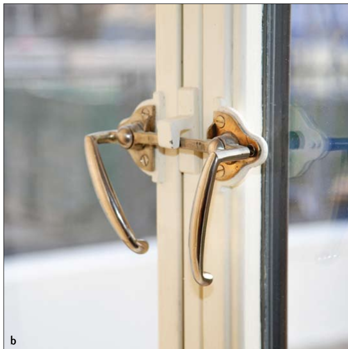
Obr. 20: Brno, Černopolní 45, vila Tugendhat: a – madlo ovládacího táhla ventilačního křídla na soisle otočném čepu, odlité z tzv. bílé mosazi; b – chromované okenní kličky na okně v kuchyni.
