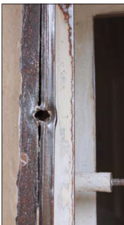
Obr. 31: Brno, Hroznová 14, vila Stiassni. Ocelové větrací okénko lodžie s průstřelem. Úlomky střely byly z rámu vyjmuty. Zdánlivě neobvyklý úkaz byl při opravách brněnských staveb zaznamenán poměrně často. Nůžkový mechanismus oken je ovládaný pákou.
