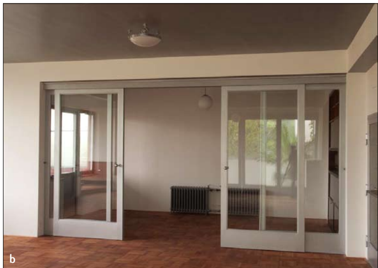
Obr. 10: Brno, Lipová 17, Žáčkova vila: a – ocelová prosklená čtyřdílná stěna osazená dvěma posuvnými křídly v reprezentativních prostorách vily. Jedná se o typický příklad dělení interiérových prostor tak, aby se opticky nezmenšoval. Ocelový rám je vytvořen z válcovaného profilu, který je vyroben přímo pro tento typ dveří a není skládán. Našroubovány jsou pouze klapáčky a zasklivač lišty. Rám je zavěšen na závěsy Perkeo kryté tvarovanou vyválnou lištou vyrobenou zřejmě přímo pro krytí tohoto typu dveří. Podlahové vedení tvoří velmi subtilní T profil o délce cca 50 mm, který je našroubován na parkety v místě krytí rámu. Osazení je provedeno tak, že při otevření i zavření křídla zůstává vedení vždy skryté. Prosklení bylo provedeno tzv. plaveným sklem o síle 8 mm, které bývalo velmi čiré a rooné, aby nezkruslovalo průhledy. V dnešní době se tato skla nahrazují sklem „diamant“.
