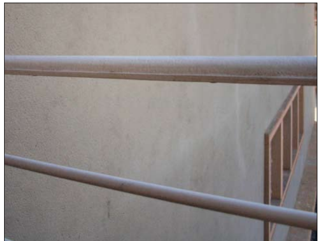
Obr. 33: Brno, Hroznová 14, vila Stiassni. Ocelové zábradlí lodžie. Patrná naprostá destrukce nátěru a poškození vlastní konstrukce masivní spárovou konstrukcí. V tomto případě bylo nutné razantně zasáhnout přímo do konstrukce zábradlí. Madlo zábradlí je složeno ze dvou snýtovaných profilů, plochého a půlkulatého. Nýty se odvtaly a oba profily bylo nutno přerovnat, opatřit několika vrstvami antikorozní bariéry Libert, znovu opatrně snýtovat tak, aby nebyla poškozena antikorozní bariéra a finálně přetřit pohledovými vrstvami. Zábradlí nebylo možné demontovat a celý technologický postup byl proveden na staubě. U všech konstrukcí meziválečné doby, které jsou v jádru skládány, je spárová koroze nejnebezpečnější jev, protože úgrobky deformuje a nelze ji odstranit tak jako korozi povrchovou. Pro odstranění spárové koroze je vždy nutné dané profily od sebe oddělit, odstranit korozi, stabilizovat povrch, nanést antikorozní bariéry a znovu profily spojit nýty nebo šrouby. Při těchto postupech vždy dochází k podstatným ztrátám autenticity.
