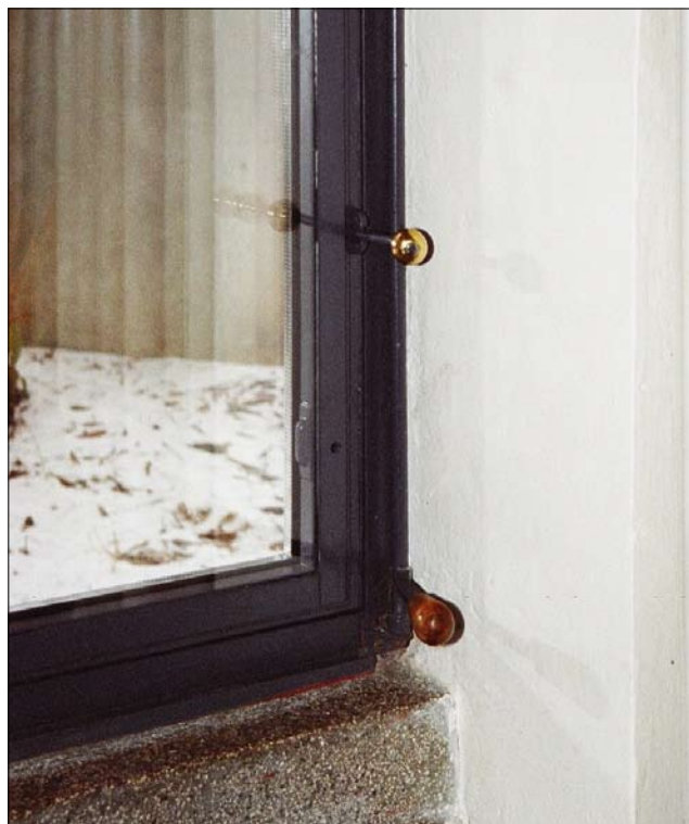
Obr. 20: Brno, Černopolní 45, vila Tugendhat: a – madlo ovládacího táhla ventilačního křídla na soisle otočném čepu, odlité z tzv. bílé mosazi; b – chromované okenní kličky na okně v kuchyni.
