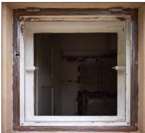
Obr. 31: Brno, Hroznová 14, vila Stiassni. Ocelové větrací okénko lodžie s průstřelem. Úlomky střely byly z rámu vyjmuty. Zdánlivě neobvyklý úkaz byl při opravách brněnských staveb zaznamenán poměrně často. Nůžkový mechanismus oken je ovládaný pákou.
