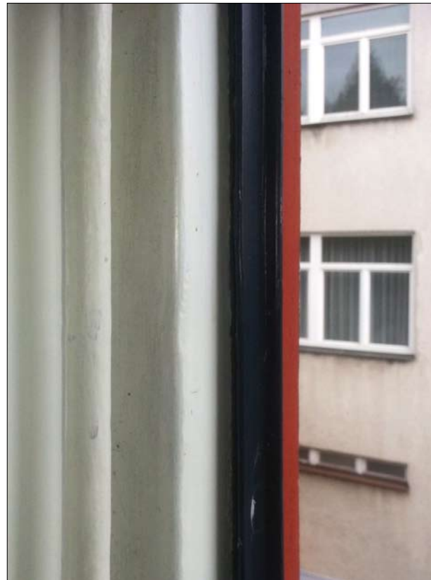
Obr. 2: Brno, Lipová 17, Žáčkova vila. Okno koupelny v patře. Složený labyrint z válcovaných profilů zabraňující pronikání chladu a vody. (Všechny fotografie M. Žáček)
