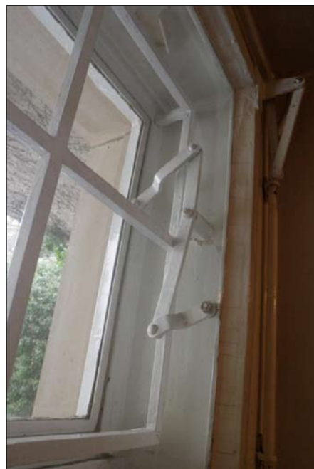
Obr. 31: Brno, Hroznová 14, vila Stiassni. Ocelové větrací okénko lodžie s průstřelem. Úlomky střely byly z rámu vyjmuty. Zdánlivě neobvyklý úkaz byl při opravách brněnských staveb zaznamenán poměrně často. Nůžkový mechanismus oken je ovládaný pákou.
